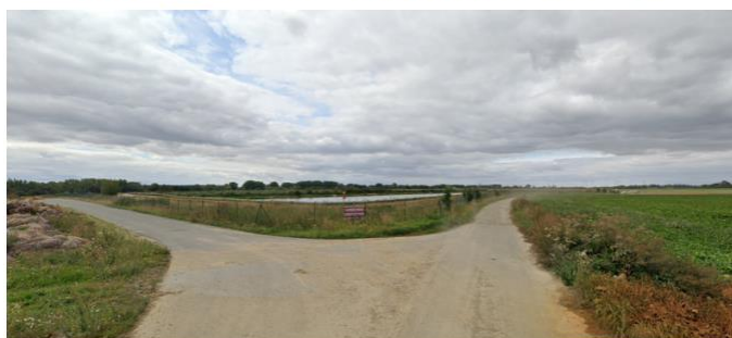
Vue 2 - Voie communale desservant la partie nord (Google Maps)
